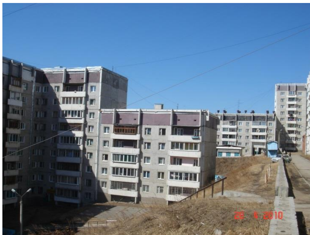
Рис. 10. Фрагмент застройки микрорайона Университетский
