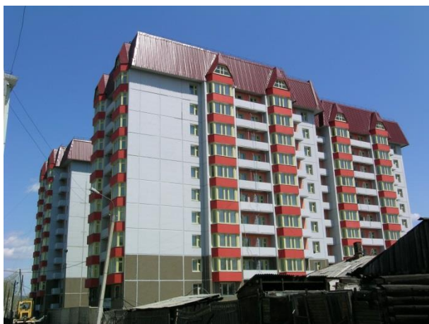
Рис. 7. Крупнопанельный жилой дом серии И-163.02/94
