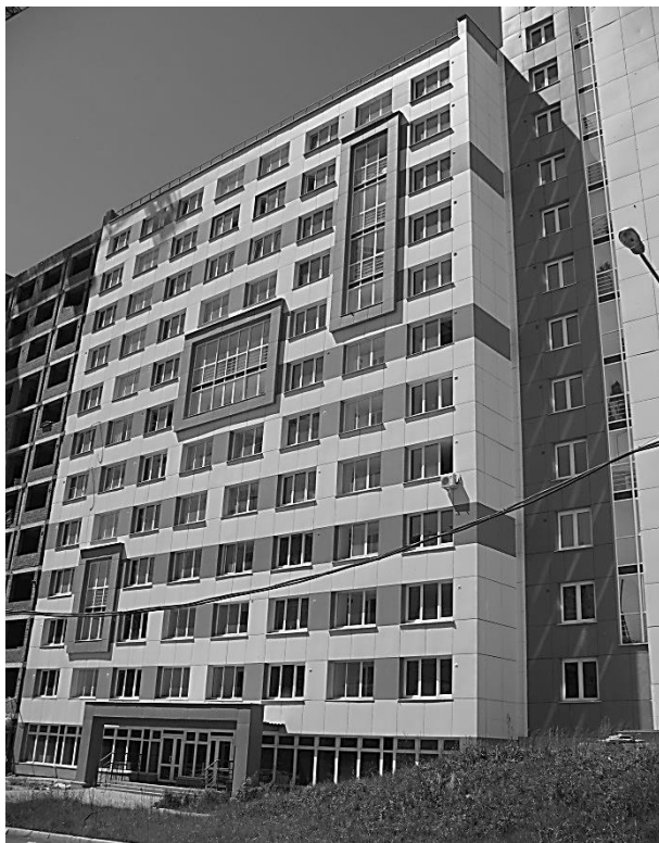
Рис. 5. Группа жилых домов в микрорайоне Солнечный по проспекту Маршала Жукова на основе конструкций и узлов серии 1.120.1-1с.
