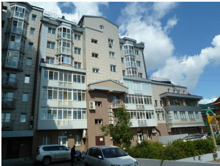
Рис. 8. Жилой дом с офисными помещениями и подземной автостоянкой (с монолитным рамно-связевым каркасом)
