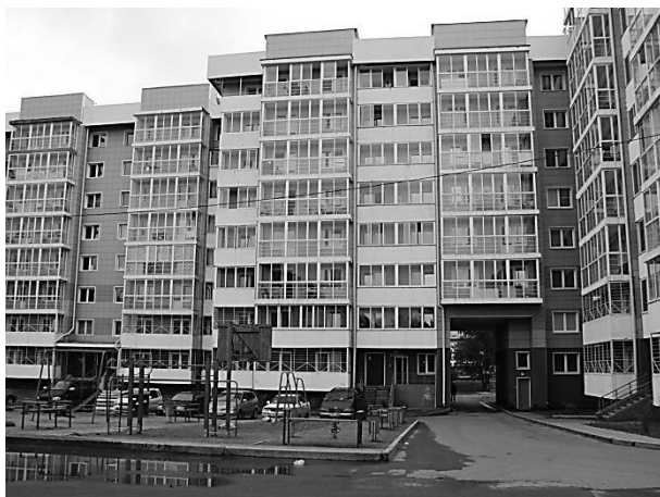
Рис. 6. 8-этажный монолитный жилой дом с рамно-связевым каркасом с кирпичным заполнением стен
